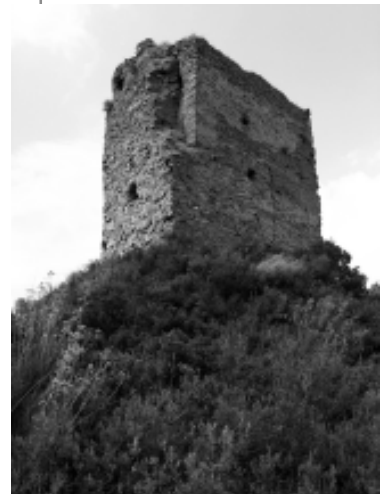
Torre del Raval
